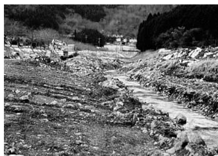
図6 改修工事（当野）
